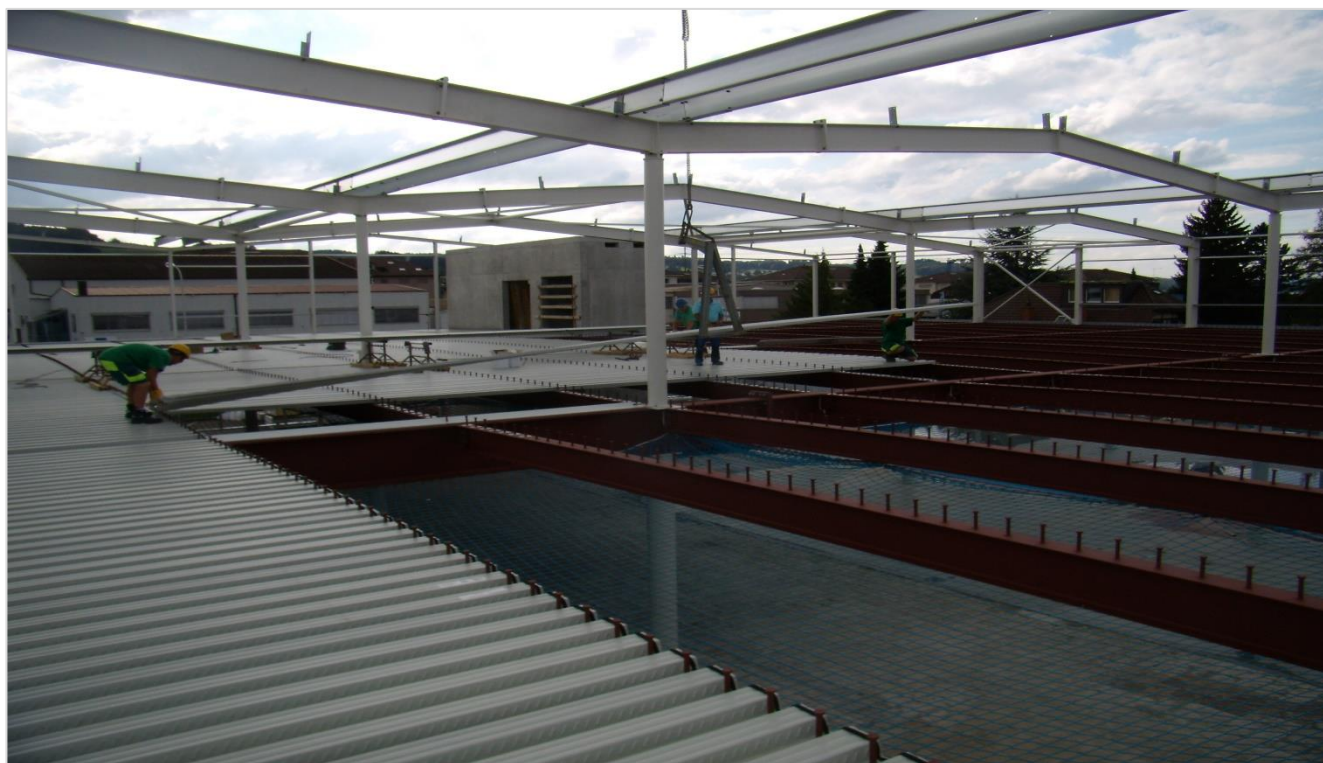
Abdichtung der Kopfbolzendübel
