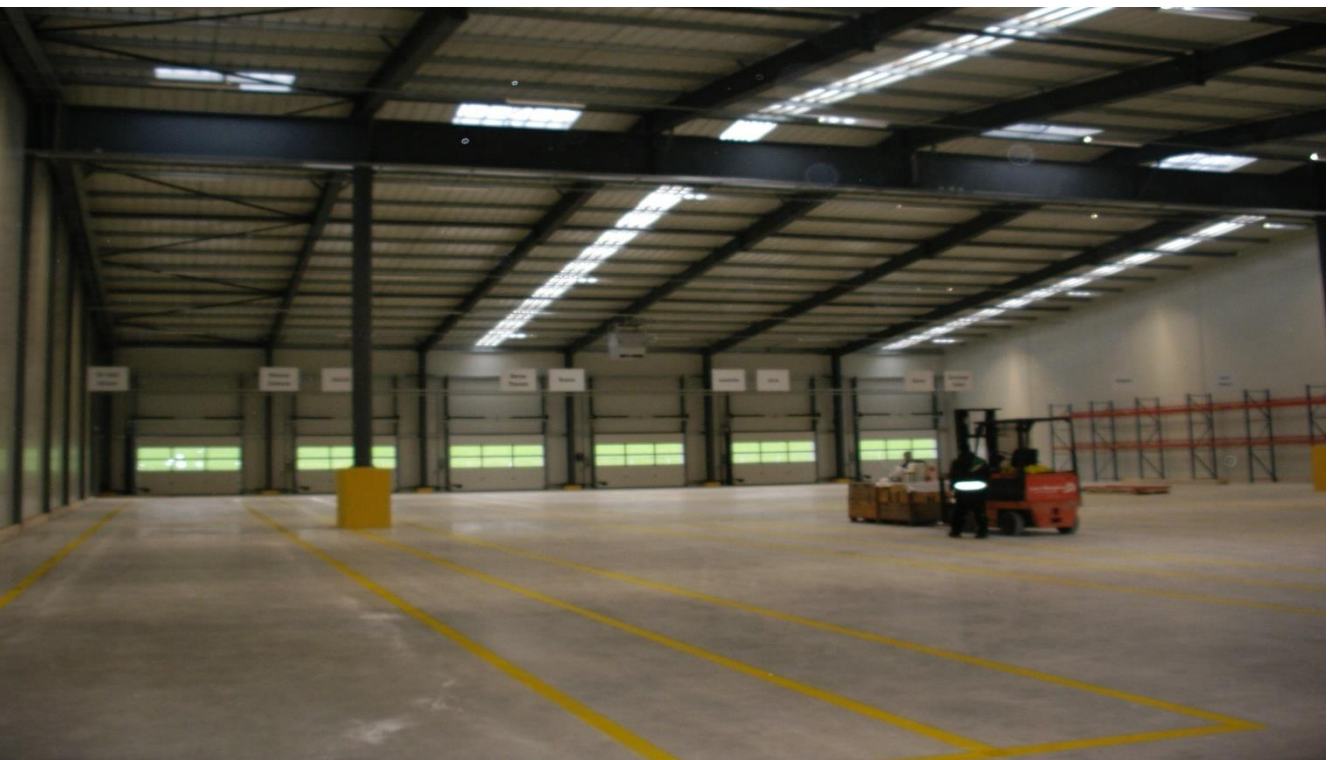
Dachausleuchtung mittels Oblichter Typ Elepress
