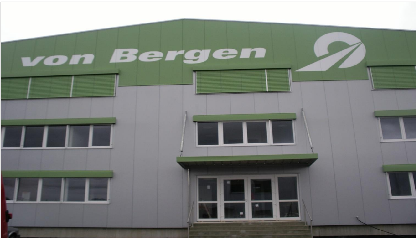
Büroteil mit Hauseingang
