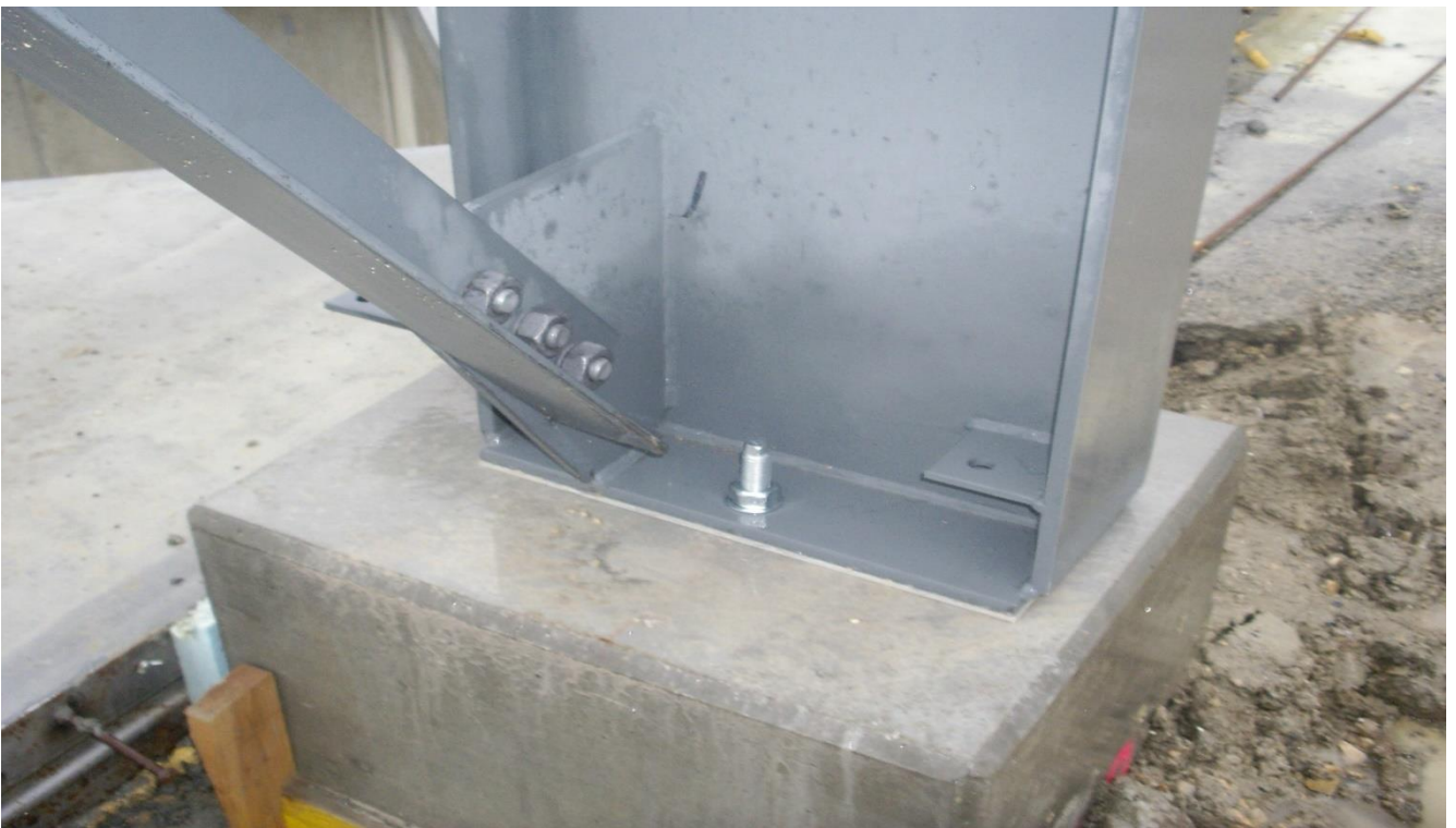
Stützenverankerung
