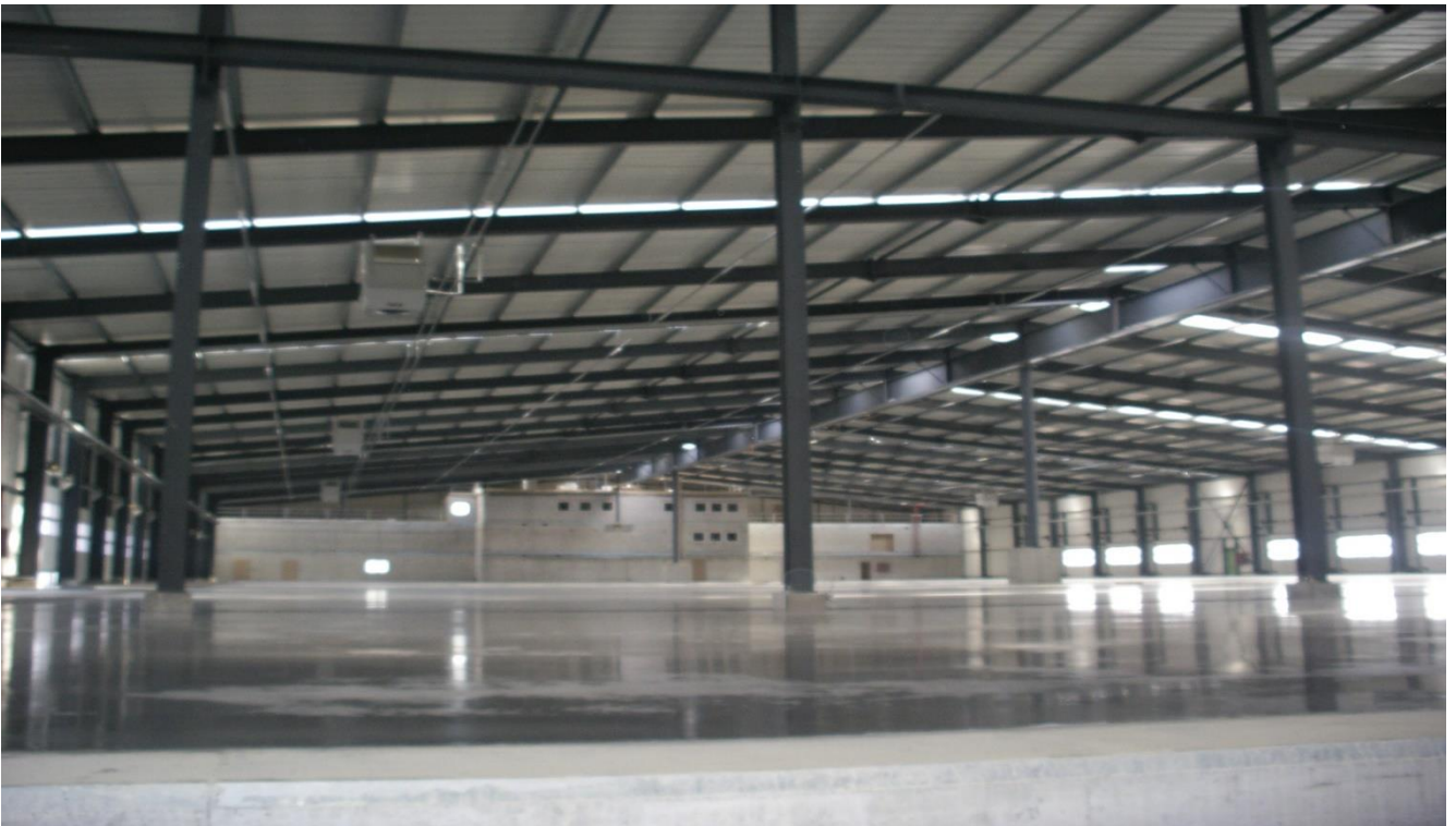
Die Betonplatte wurde in 3 Tagen eingebaut (8'710 m 2 )
